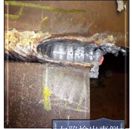
欠陥検出事例
